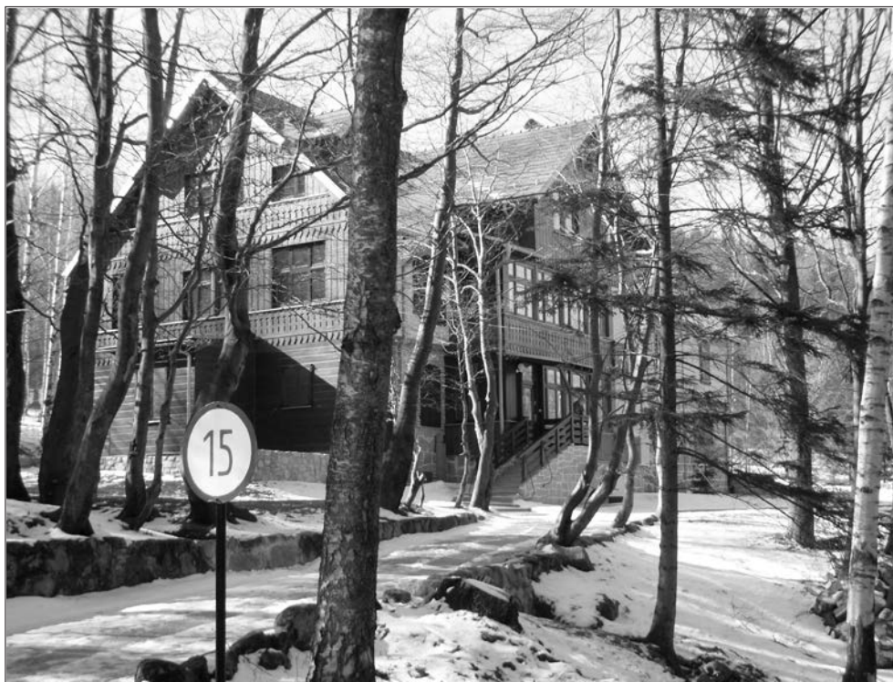
Budynek Stacji Ekologicznej UWr w Karpaczu
