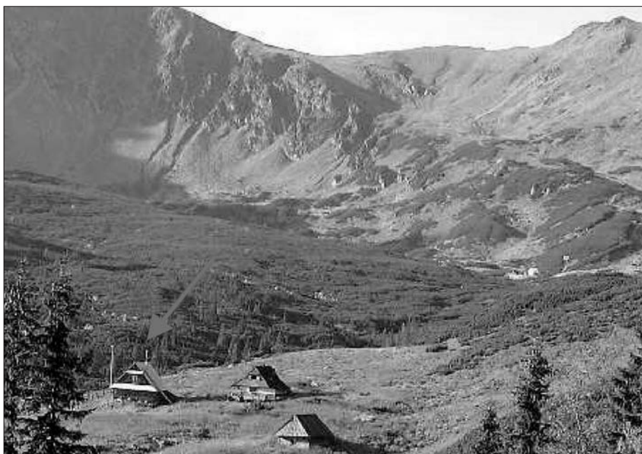
Budynek Stacji Badawczej im. Marii i Mieczysława Kłapów IGiPZ PAN na Hali Gąsienicowej
