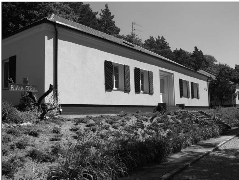
Budynki Stacji Monitoringu Środowiska Przyrodniczego UAM w Białej Górze
