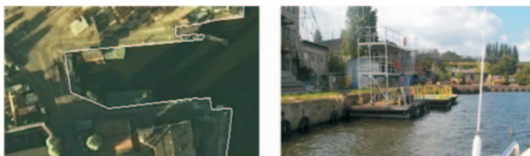
Rys. 9. Mniejsze konstrukcje pływające w basenie portowym.
